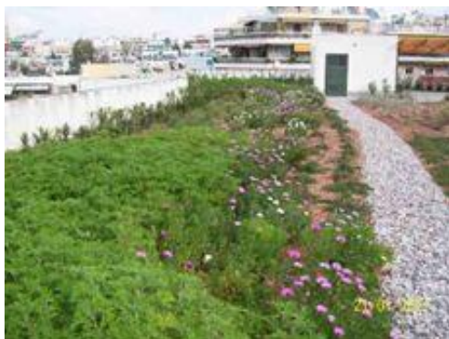
Εικόνα 5. Η στέγη του 4 ο Δημοτικό σχολείο Νέας Σμύρνης Πηγή : http://4dim-n-smyrn.att.sch.gr/
