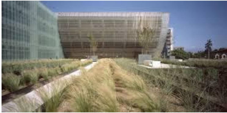
Εικόνα 6. Κτίρια Γραφείων Shop & Trade (2010) Κοκκίνου-Κούρκουλας. Πηγή : http://www.kokkinoukourkoulas.com/el/shop-trade-office-building/
